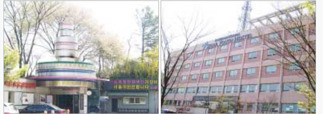
유스호스텔은 과거 국가안전기획부 본부였다. 영문자 HOSTEL의(오른쪽 사진) 끝부분에 해당하는 곳에 안기부장의 사무실이 있었다.
