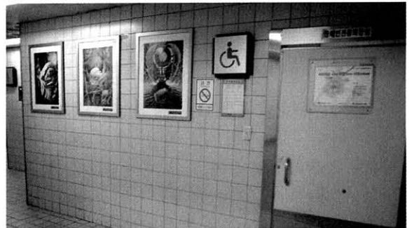
비장애인들이 무심코 지나는 장애인들의 남여 공동화장실. 장애인 화장실을 지으면서 어떻게 남성과 여성을 구분하지 않고 만들었을까.
