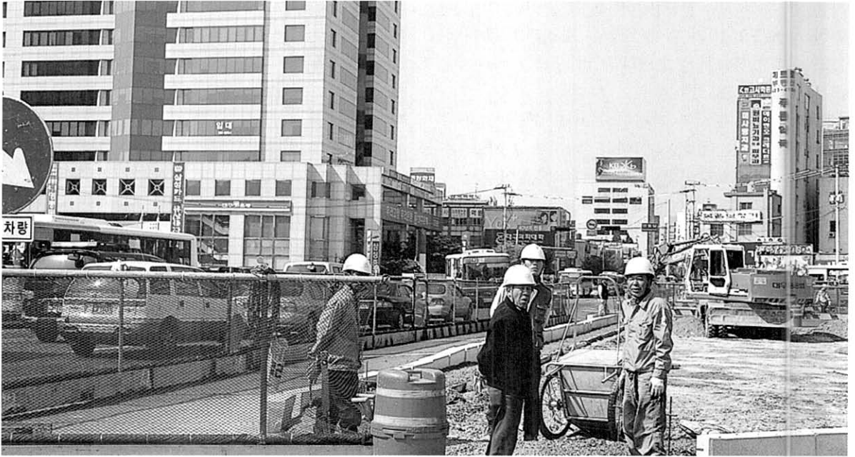
2·28학생운동 당시 경북고와 대구고 등 대구 시내 학생들이 집결했던 반월당에서는 지하철 2호선 공사가 한창이다.
